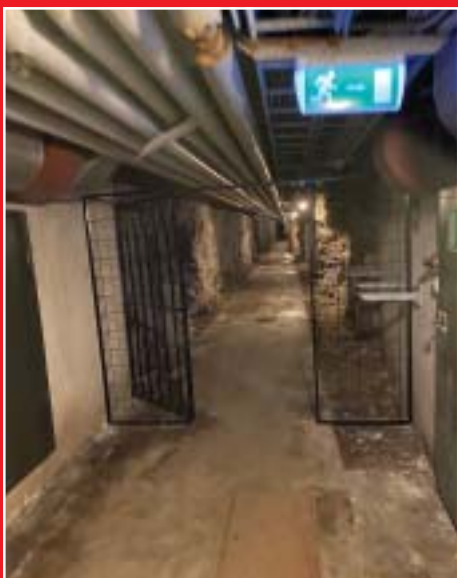
Förbindelsegång i anläggningen
